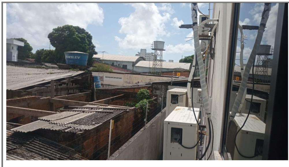
**3.2.** As unidades condensadoras deverão ser instaladas no lado externo do prédio, na mesma direção das unidades evaporadoras, apoiadas no passeio existente.
